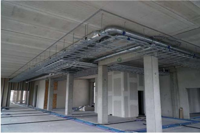
Absenkung der baulichen Deckenhöhe in ausgewählten Abschnitten zur einfacheren (kollisionsfreien) Verlegung von Unterdeckeninstallationen – Bürogebäude Campus Loddenheide, Deutschland
