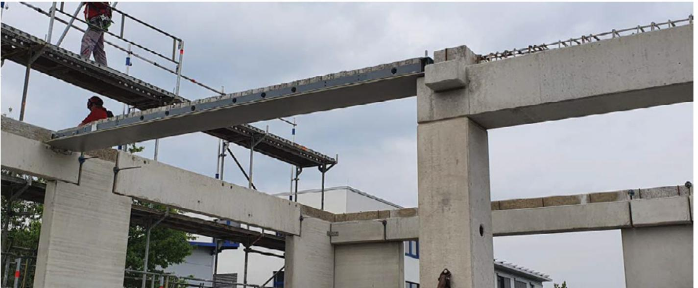
Die Beseitigung oder Verringerung der Höhe der überstehenden Balken unter der Decke erleichtert die Ausführung der Installation bei optimalem Einsatz von Material und Personal.
