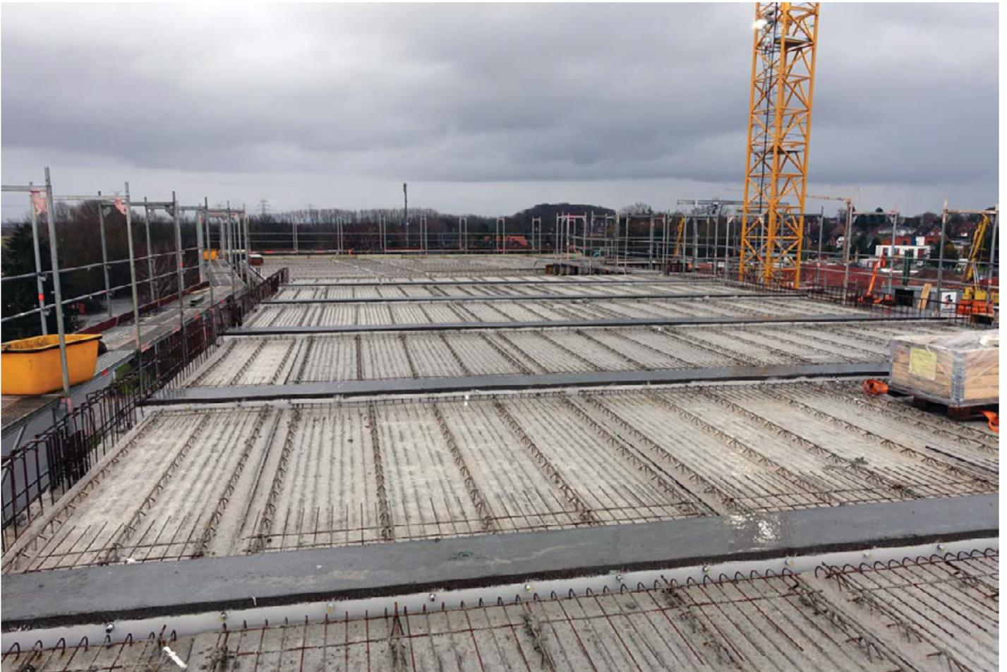
Abgehängte, vorgefertigte Plattenträger für Elementdecken
