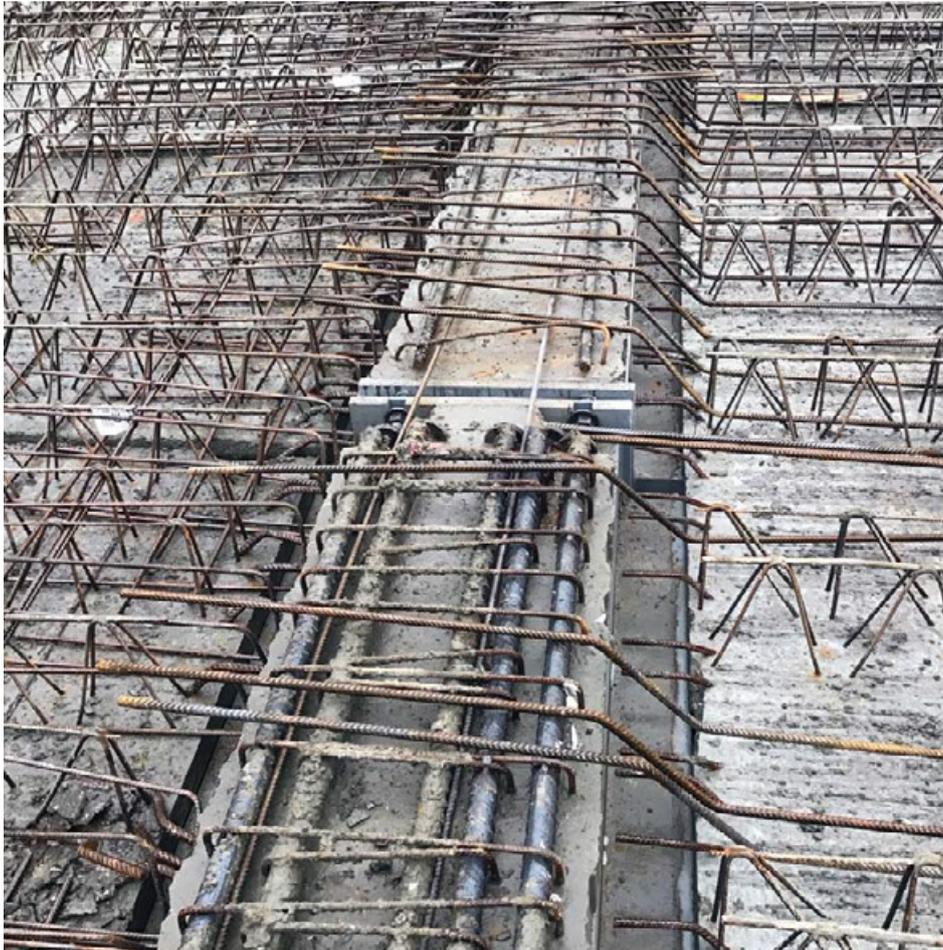
In einigen Fällen kann die Höhe des Hybridträgers aus statischen Gründen die angenommene Dicke der Deckenplatte überschreiten. Je nach den Möglichkeiten und Anforderungen des Bauplaners kann es möglich sein, die Oberkante des Trägers über die Oberkante der Deckenplatte (10) anzuheben. Ein möglicher Anschluss an die obere Bewehrung der Deckenplatte (falls erforderlich) erfolgt über biegbare oder schraubbare Bewehrungsanschlüsse.
