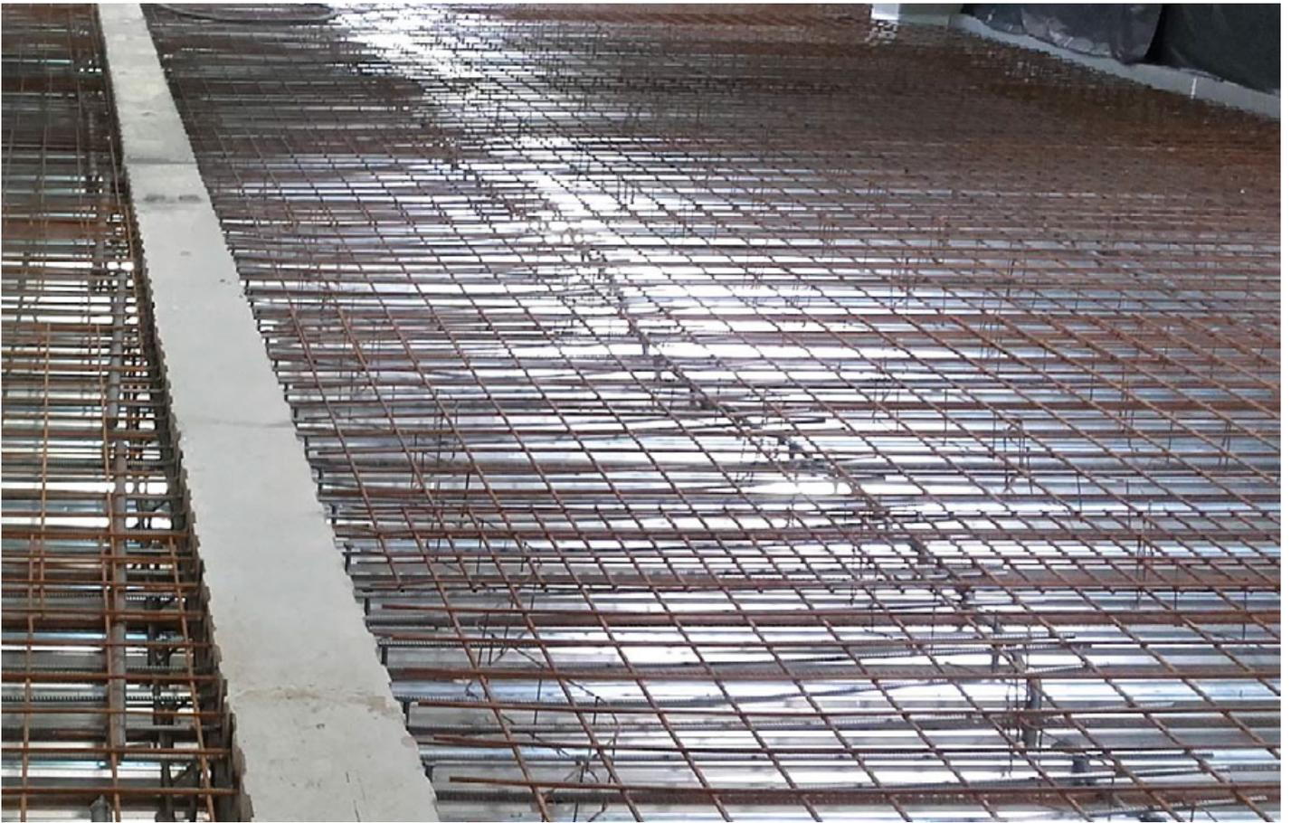
Hybridbeams für Verbunddeckenplatten auf Trapezblech mit gleicher Höhe wie die Deckenplatte
