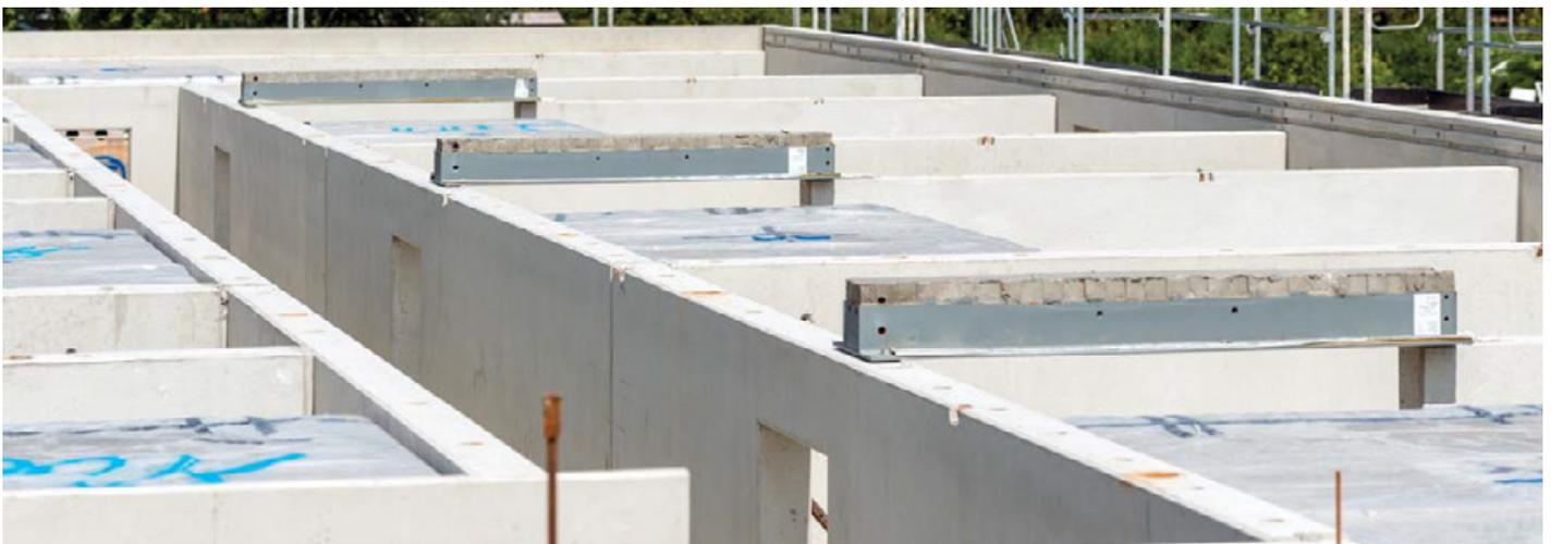
Wenn die Druckspannungen den zulässigen Wert überschreiten, sollten Übertragungsplatten verwendet werden, die die Lastabtragungsfläche effektiv vergrößern und eine Umverteilung an der vom Statiker vorgesehenen Stelle ermöglichen. Abbildung (B) zeigt ein Beispiel, wie eine solche Unterstützung realisiert werden kann.
