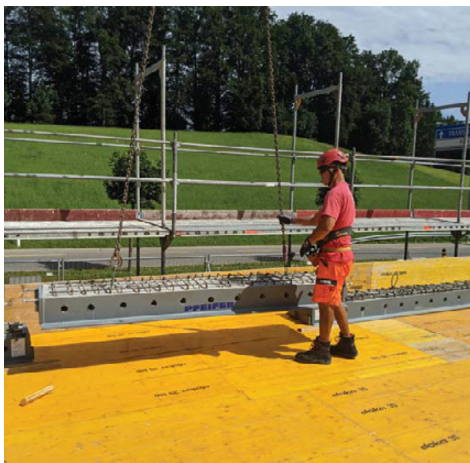
Belka ciągła przewieszona nad podporą
