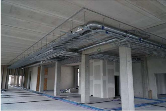
Absenkung der baulichen Deckenhöhe in ausgewählten Abschnitten zur einfacheren (kollisionsfreien) Verlegung von Unterdeckeninstallationen – Bürogebäude Campus Loddeneide, Deutschland
