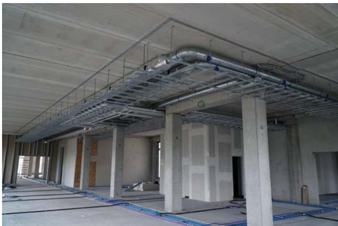
Obniżenie wysokości konstrukcyjnej stropu na wybranych fragmentach w celu prostego (bezkolizyjnego) poprowadzenia instalacji podstropowych – biurowiec Campus Loddenheide, Niemcy
