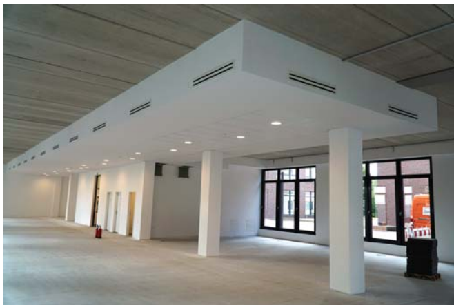
Obniżenie wysokości konstrukcyjnej stropu na wybranych fragmentach w celu prostego (bezkolizyjnego) poprowadzenia instalacji podstropowych – biurowiec Campus Loddenheide, Niemcy
