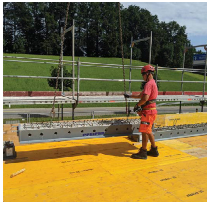
Durchgehender Träger, der über eine Stütze auskragt
