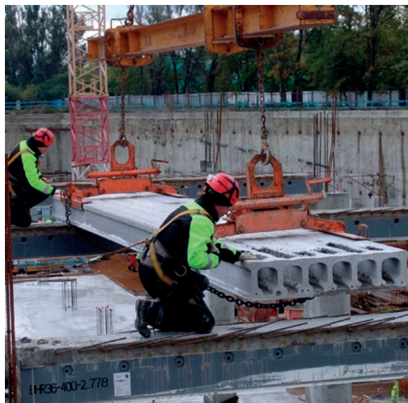
PFEIFER Hybridbeam® – niska, wytrzymała, a jednocześnie stosunkowo lekka zespolona belka stalowo-betonowa
