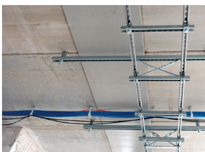
Fot. 7. Belka PFEIFER Hybridbeam®. Podkonstrukcja z szyn montażowych do mocowania instalacji
