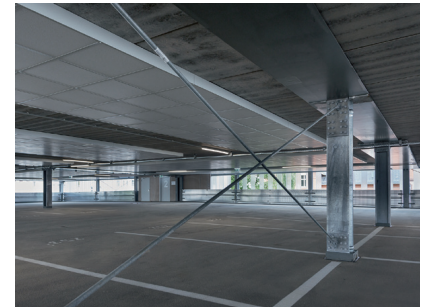
Fot. 3. Parking w Bernau, Niemcy – belka środkowa PFEIFER Hybridbeam® wraz z płytami kanałowymi
