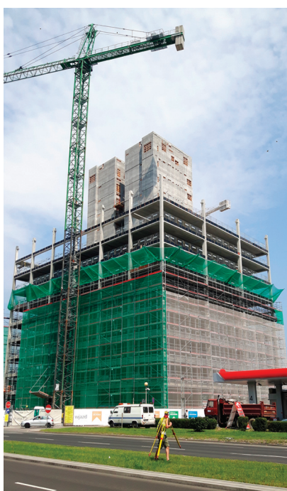
Fot. 6. Monolityczny trzon z zewnętrzną konstrukcją prefabrykowaną biurowca WAVE w Gdańsku
