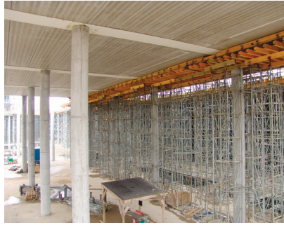
Fot. 1. Galeria Młociny w Warszawie – porównanie stropu prefabrykowanego z belkami PFEIFER Hybridbeam® (po lewej) ze stropem przygotowanym pod technologię monolityczną (po prawej)
