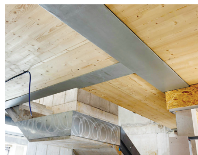
Fot. 9. Biurowiec w Lienzu, Austria – połączenie belek PFEIFER Hybridbeam® ze stropem z drewnianych płyt klejonych
