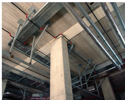
Fot. 2. Belka PFEIFER Hybridbeam® wraz z płytami kanałowymi w galerii Młociny w Warszawie – strop slim floor ułatwia montaż instalacji HVAC
