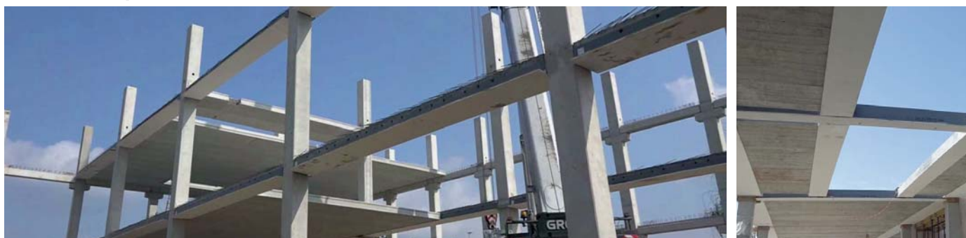
Budynek przemysłowy, Wołomin
