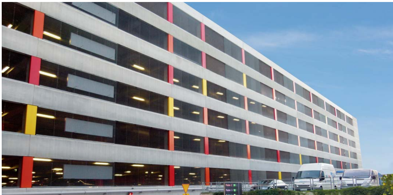
Parking wielopoziomowy Galerii Echo, Kielce
